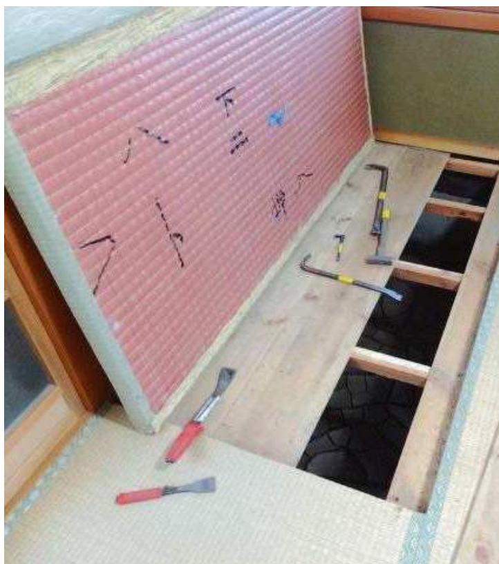
和室の床板をはがす（写真①）
