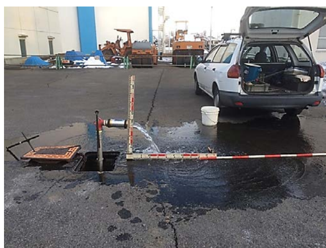
本管口径 \phi 100 の場所について 消火栓スタンドより 30cm 以下の水で使用
