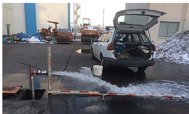
本管口径 \phi 200 の場所について 消火栓スタンドより 120cm 以下の水で使用
